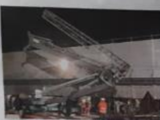
L'operazione di rimozione della gru durante la notte
