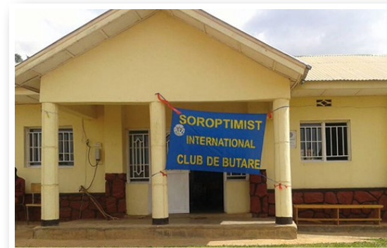
Ristrutturazione della Maison des femmes
